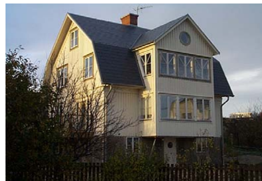
VILLA SVANHOLM, Hönö, bostad och kontor Om- och tillbyggnad av skärgårdshus från 30-talet
